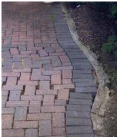
Insufficient edge restraint
